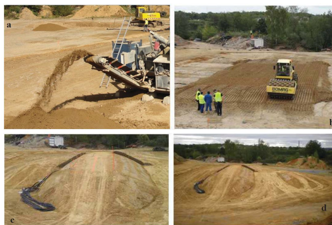
FIG. 1.28 – Réalisation des digues expérimentales : (a) production du matériaux traité, (b) mise en place et compaction avec un rouleau à pieds dameurs, (c) vue générale de l’ouvrage en sol traité, (d) vue générale des deux digues (en sol traité à gauche, en sol non traité à droite) [40].
