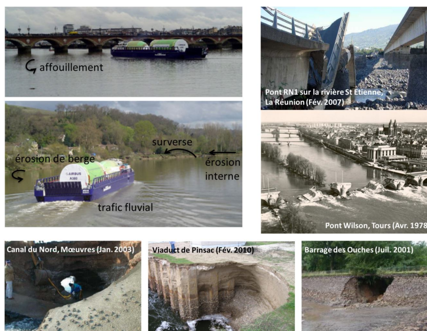
FIG. 1 – Processus d'érosion : diversité des phénomènes et exemples de ruptures ou de désordres sur les ouvrages.
