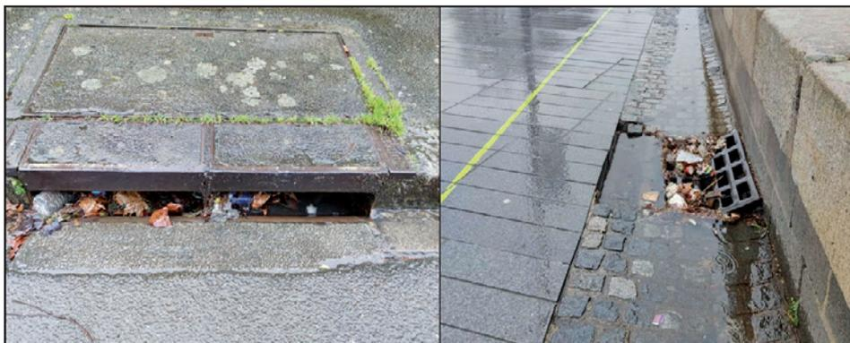
Figure 6. Exemples d'accumulation de déchets au niveau d'avaloirs à paroi siphonoïde (à gauche) ou à grille (à droite)
