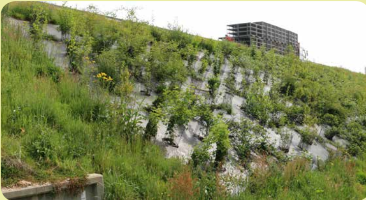
Couverture plastique d'un remblai planté de jeunes arbres
