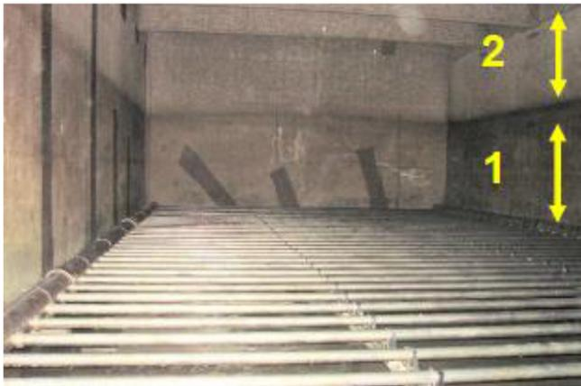
Fig. 4. État du béton sous le plancher du biofiltre de la station Seine Centre (zone 1 : sous le massif de billes ; zone 2 : massif de billes) [7].
