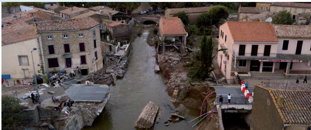
Les restes du pont de Villegailhenc emporté par l'inondation Photo Sébastien Gominet/IRMA
