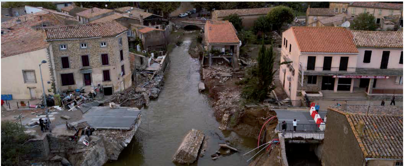
Les restes du pont de Villegailhenc emporté par l'inondation Photo Sébastien Gominet/IRMA
