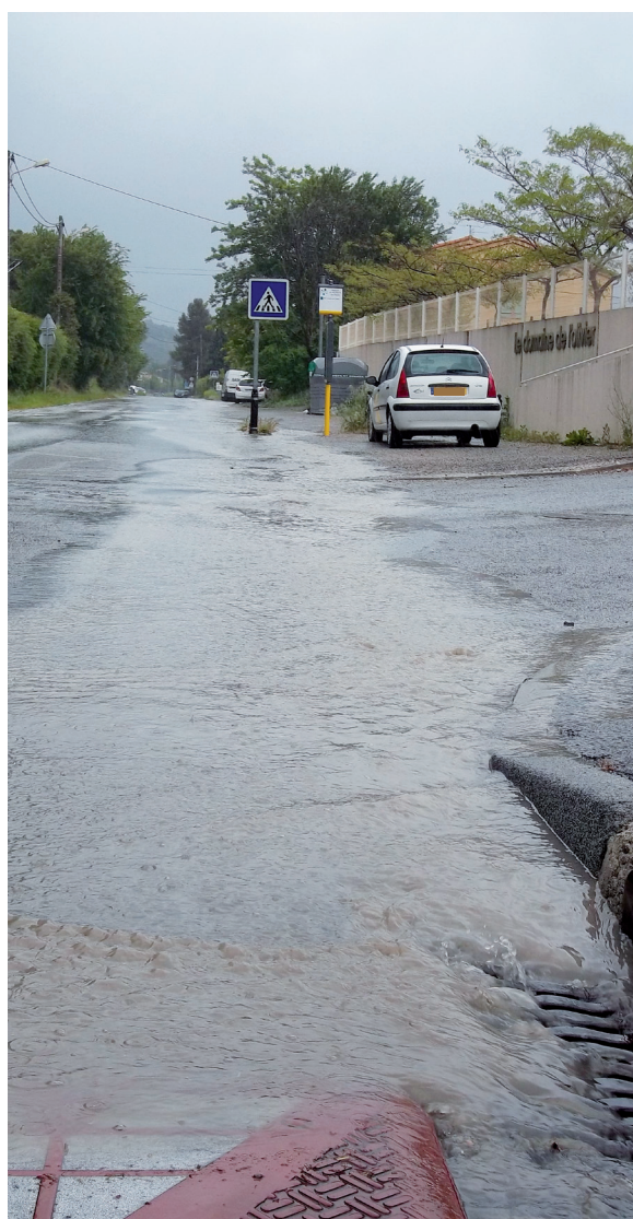
Ruissellement pluvial à Gardanne, dans les Bouches-du-Rhône, en 2012 © Syndicat d'Aménagement du Bassin de l'Arc (SABA)
