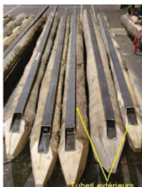
Figure 5. Fixation des tubes extérieurs dans la saignée
