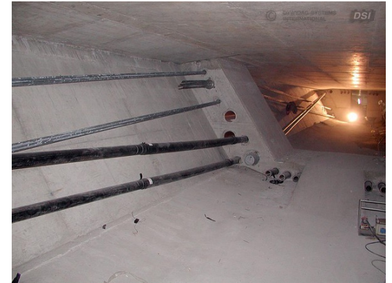
Pont à caisson pré contraints
