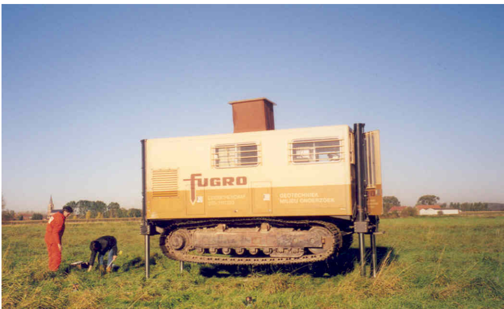
Figure 17 Réalisation des pénétromètres
