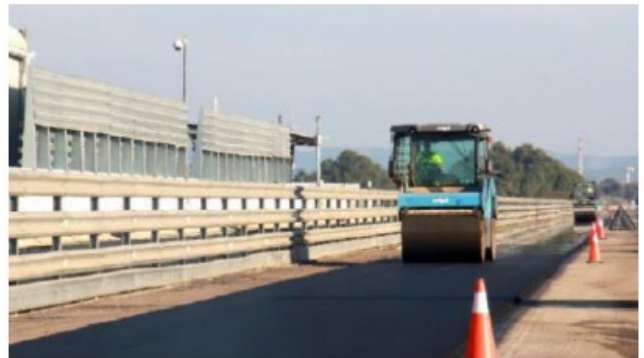
Figure 3: Préparation de la chaussée du circuit test à IDIADA. Extrait de Leiva-Padilla, P., Schmidt, F. (2022). Assessment of platoon axle loads on road infrastructure. D4.1 of H2020 project ENSEMBLE.
