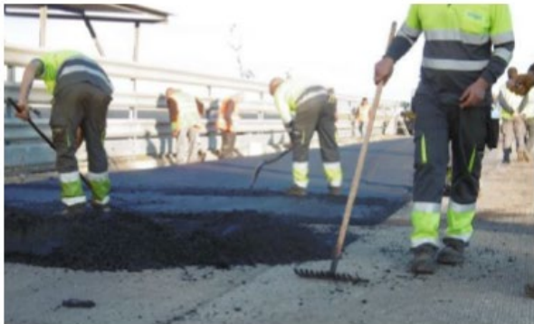
Figure 3: Préparation de la chaussée du circuit test à IDIADA. Extrait de Leiva-Padilla, P., Schmidt, F. (2022). Assessment of platoon axle loads on road infrastructure. D4.1 of H2020 project ENSEMBLE.
